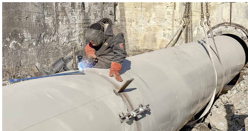
© Между берегом и ТЭЦ обновляется крупный участок трубопровода. Фото: Александра Зуева
