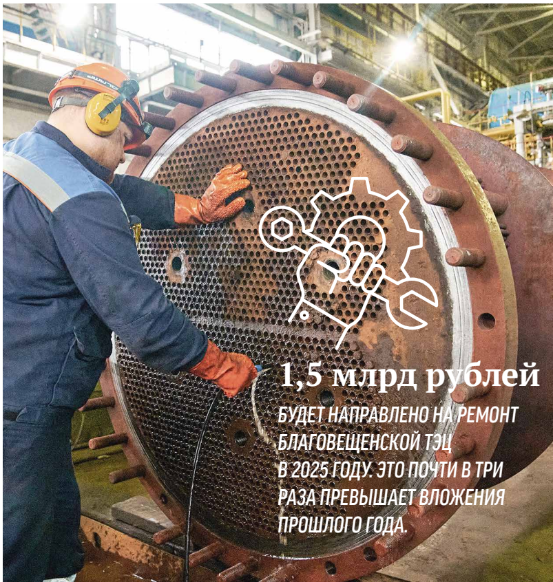
Ремонтная кампания на теплоцентрали стартует 1 марта. Фото: Анна Баклыкова
