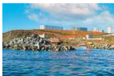
Если акваторию водозаборного ковша своевременно не очистить, во время ледостава станции может не хватить воды для технологических нужд. Фото пресс-службы Приморской генерации
