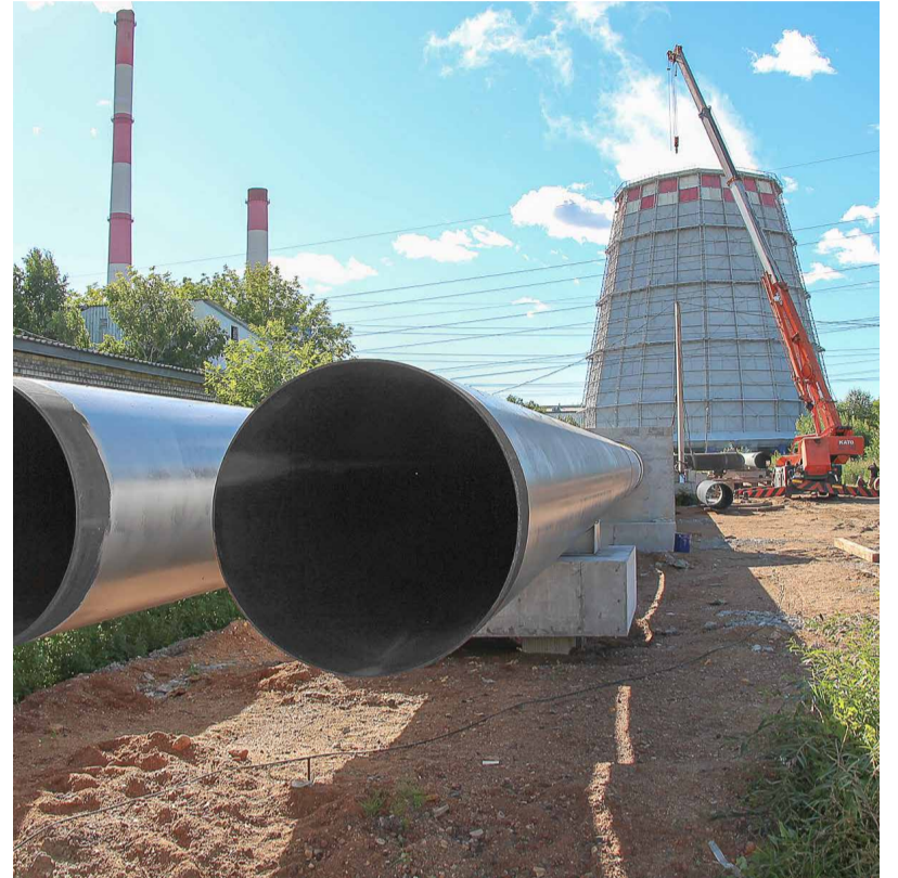
© Для увеличения пропускной способности теплосетей энергетики АТС заменяют трубы диаметром 800 мм на более широкие — 1000 мм. Фото: Анна Баклыкова
