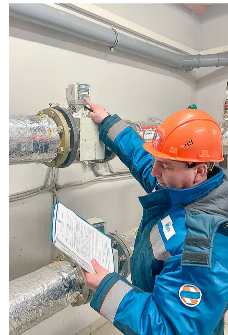
© Проверка приборов учета тепловой энергии у потребителей. Фото: ХТС
