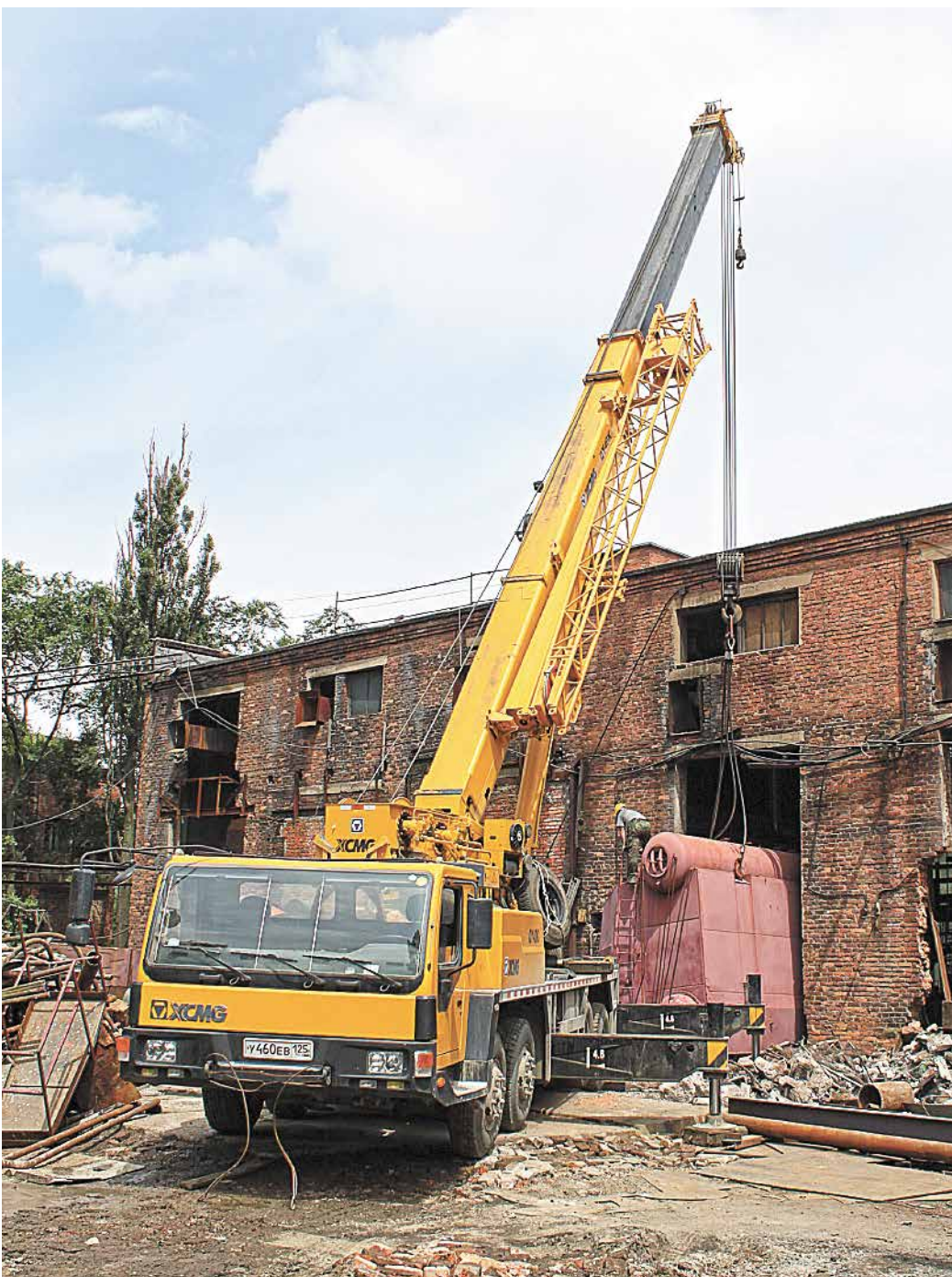
УСТАНОВКА КОТЛА ДЕ-16 В КОТЕЛЬНОЙ «ВТОРАЯ РЕЧКА», 2010 ГОД
