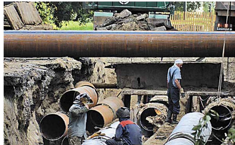
ИСПЫТАНИЯ И РЕМОНТ ТЕПЛОВЫХ СЕТЕЙ — ВАЖНАЯ ЧАСТЬ ПОДГОТОВКИ КАЖДОГО ФИЛИАЛА К ОЗП
