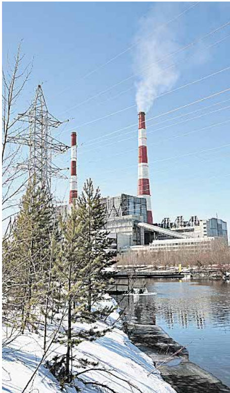
НА НЕРЬОНГРИНСКОЙ ГРЭС ОТОПИТЕЛЬНЫЙ СЕЗОН НАЧАЛСЯ РАНЬШЕ ВСЕХ
