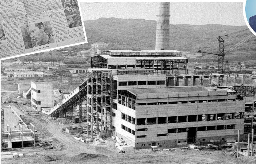
© Строительство главного корпуса Владивостокской ТЭЦ-2. 1968 год. Все фото: архив пресс-службы ДГК
