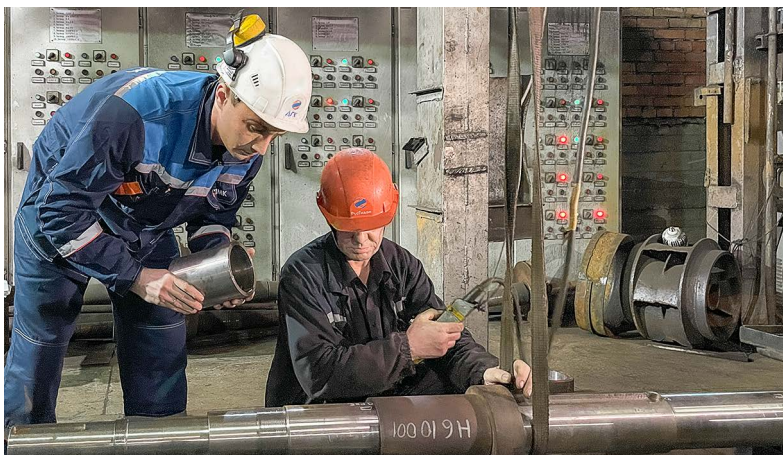
Сразу на нескольких ремонтных местах на ТЭЦ ведется ремонт основного и вспомогательного оборудования станции. Фото: Семен Симоненко
