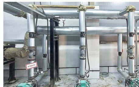
Внутри ЦТП завершаются работы по модернизации объекта. Фото: Павел Тарабанов
