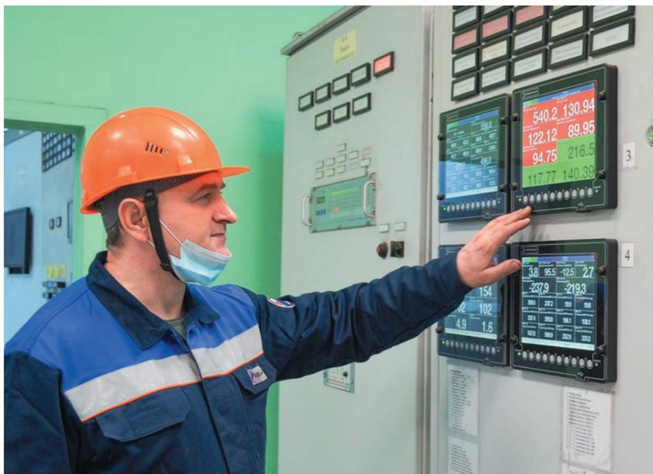
Ежедневно нужно осмотреть оборудование, закрепленное за техгруппой, в данном случае — котлоагрегат № 7. Александр Викторович проверяет датчики наличия факела в топке котла, температуры перегретого пара, уровня воды и другие. Проверяются и приборы срабатывания сигнализации. Сегодня все работает нормально! А если есть отклонения, мастер сообщает об этом оперативному персоналу и начинает планировать ремонт оборудования.
