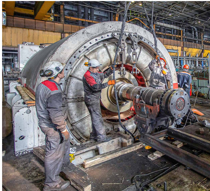
① Ремонтные работы на Нерюнгринской ГРЭС. Фото: Роман Зарышнюк
