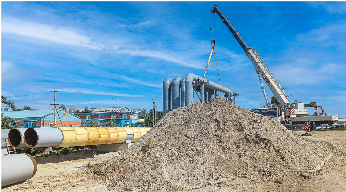
© Реконструкция тепломатриалей № 1 Центрального района Благовещенска. Работы проходили в 2024 году и будут продолжены в 2025-м. Фото: Анна Баклыкова
