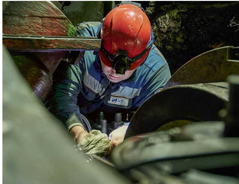
© Ремонтные работы на Благовещенской ТЭЦ. Фото: Анна Баклыкова
