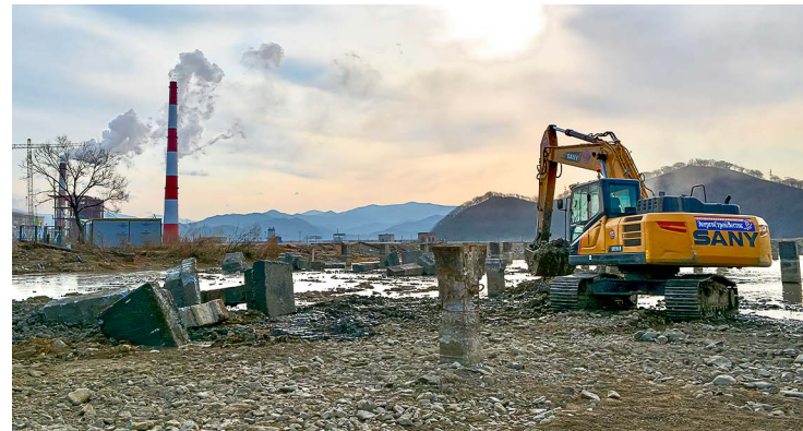
© Энергетики ПГРЭС меняют разрушенные трубопроводы и железобетонные опоры в секции № 3 брызгального бассейна. Фото: Татьяна Николаева
