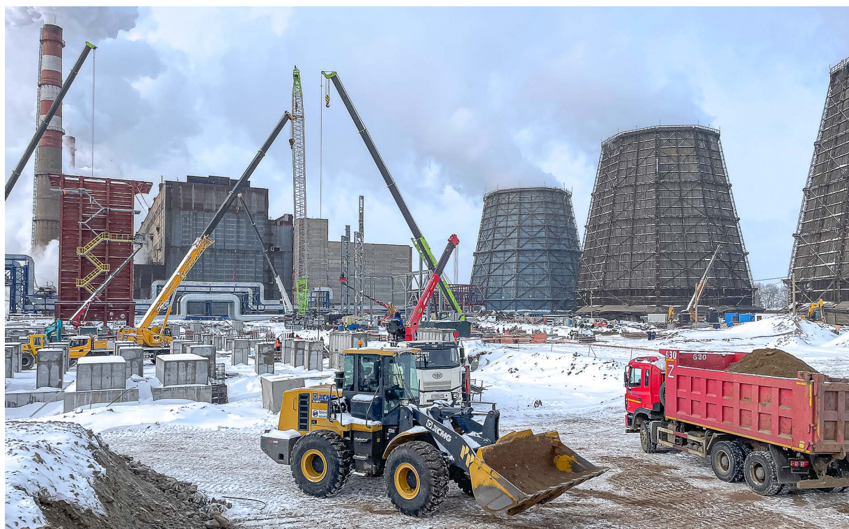
© Ведется возведение главного корпуса станции — в нем будет размещено генерирующее оборудование. Фото: Семен Симоненко
