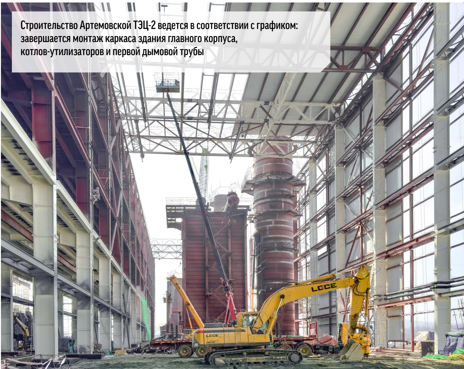
© Внутри корпуса ведутся установка оборудования, устройство межэтажных перекрытий и внутренних перегородок. Фото: Александра Зуева
