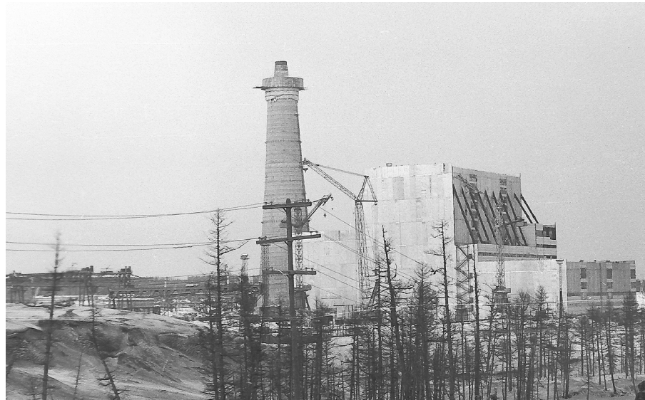
© Строится первый энергоблок Нерюнградской ГРЭС. 1981 год. Фото: семейный архив героя
