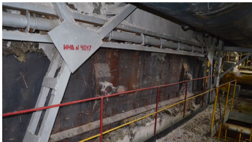
© Началась реконструкция: идет демонтаж изоляции котлоагрегата № 6 Хабаровской ТЭС-2. Фото Марины Булдыгеровой
