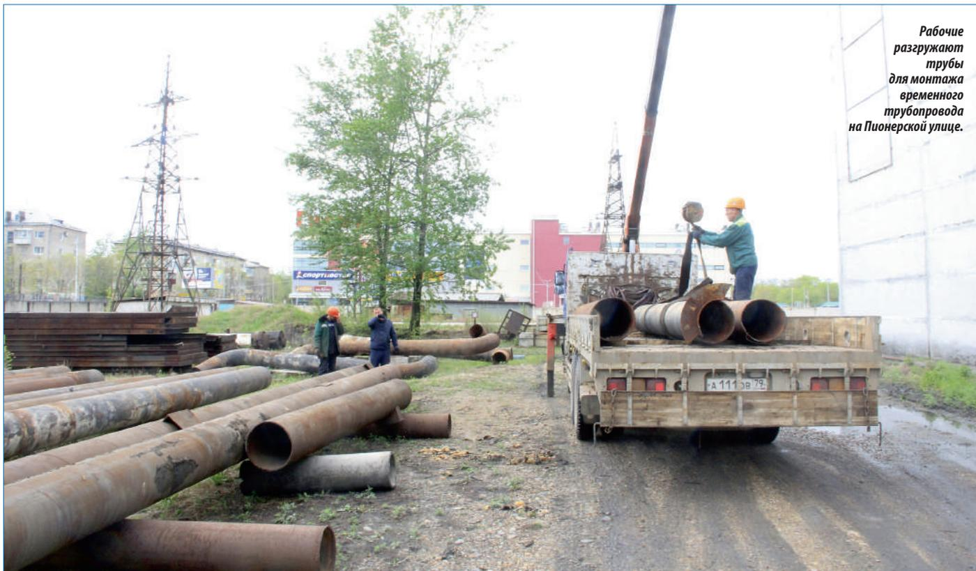
Рабочие разгружают трубы для монтажа временного трубопровода на Пионерской улице.
