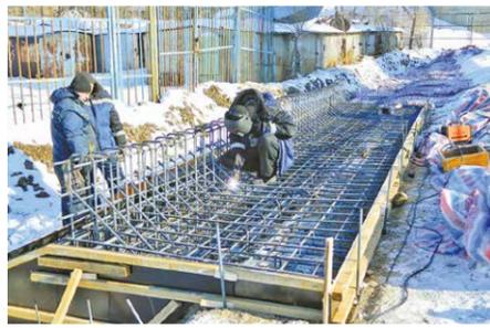
ского сооружения завершится, на вершине дамбы будет создано основание под стену — «подошва», на которой расположится сама двухметровая бетонная стена. Стоит отметить, что строительство «подошвы» под стену уже началось, 125 метров основания установили на вершине берега, сейчас идут работы по сооружению самого бетонного ограждения. Общая длина будущей конструкции составит более 470 метров вдоль прибрежной линии.
