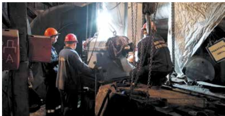
Специалисты заменяют корпус дутьевого вентилятора.
