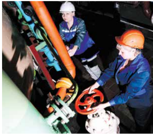
В числе работ – ремонт арматуры
