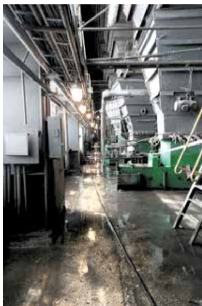
Специалисты ведут плановый ремонт оборудования
